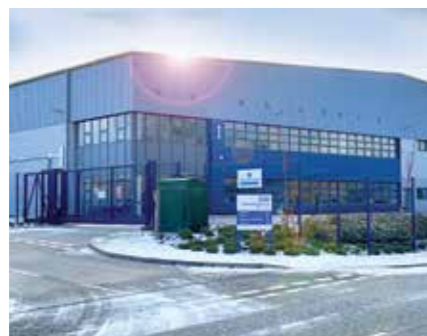
Eines von 6 „Leuchtturm“-Covid-19-Testlaboren, die im konzerneigenen Gewerbegebiet Baltic Park im Nordosten Englands gebaut werden.
