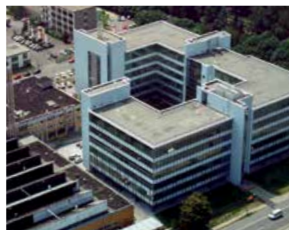
Am Manroland-Standort Senefelderhaus wurde 2020 der Umbau zur Polizeiakademie fortgesetzt.
