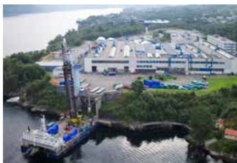
Das Werk Bergen Engines AS in der Nähe von Bergen, in Norwegen
