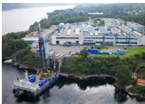
Las instalaciones de Bergen Engines AS cerca de Bergen, en Noruega.
