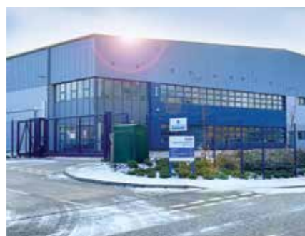
Un des 6 laboratoires de référence pour les tests anti-Covid-19 au Royaume-Uni, installé dans l'ensemble immobilier Baltic Park du Groupe, dans le nord-est de l'Angleterre.
