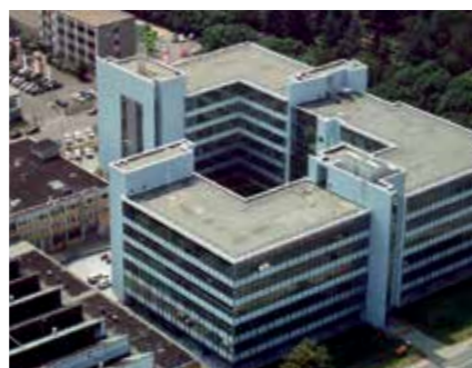
I lavori sono continuati nel 2020 presso lo stabilimento di Manroland a Senefelderhaus per la conversione in accademia di addestramento per la polizia.
