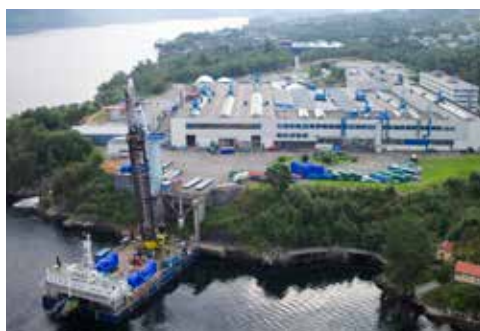
A planta da Bergen Engines AS, próximo a Bergen, na Noruega
